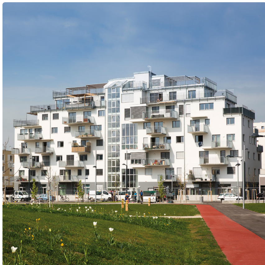
Wohnhausanlage BROT Aspern | AT
