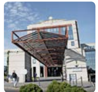
SIG Energieservices | CH
